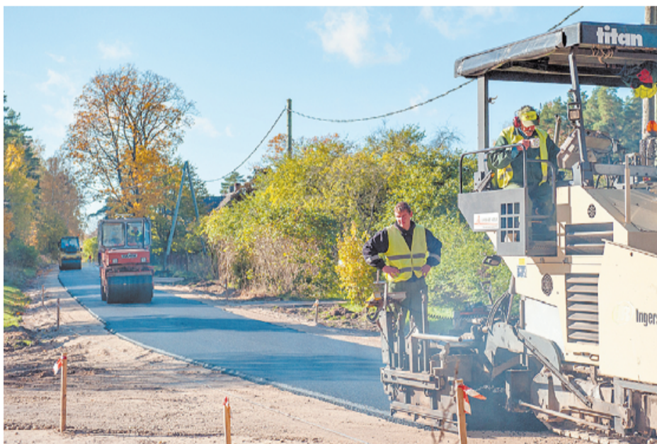
Rit asfalta klāšana Edgara Liepiņa ielā Skultē
